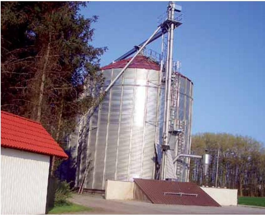
Getreidelagerung mit Kippeinrichtung, Rohrschnecke, Abdeckung und Wiegehaus. Foto: Moe
