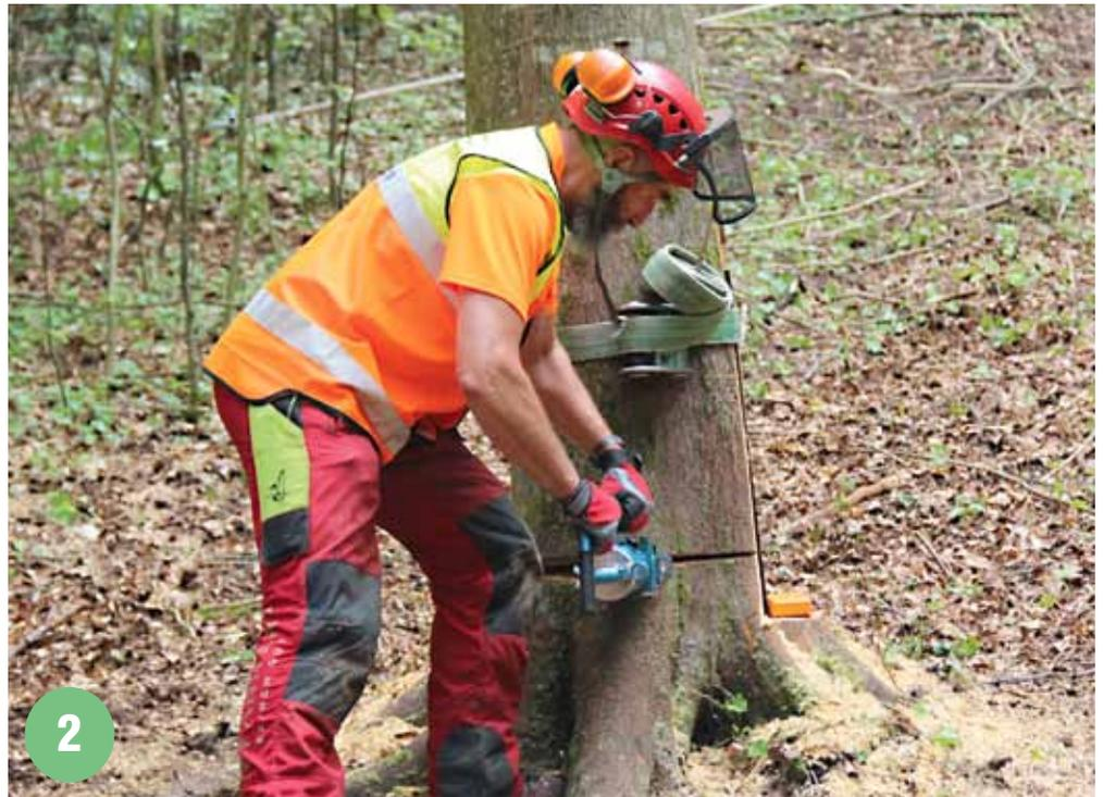
*Paul Bischof rammt den Fällkeil in den Fällschnitt, zuvor hat er diesen am gewünschten Stück etwas ausgesägt zu einem offenen Mund, sodass der Keil optimal passt.*
