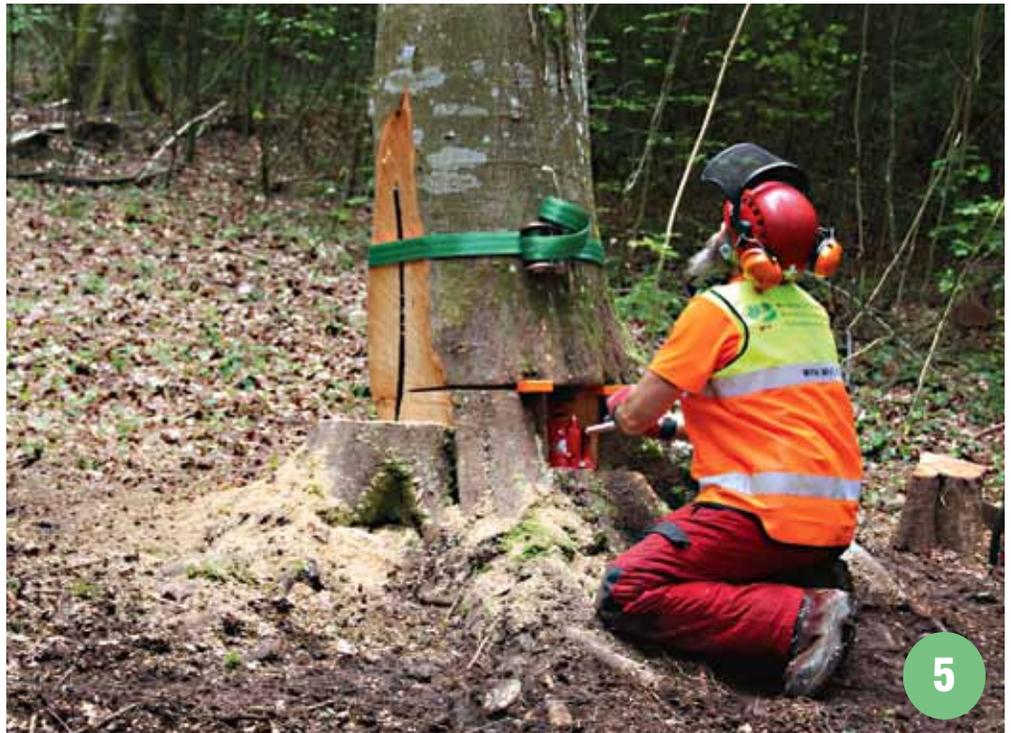
Während der Hebel des Fällhebers gleichmäßig betätigt wird, kann man genau die Krone beobachten. Beim Fällheber gibt es kein Zurückschwingen des Baumes wie beim Keilen mit dem Spalthammer, das verhindert den Fall von Totästen.
