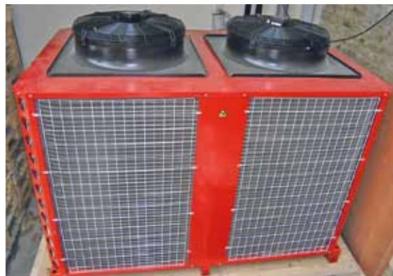
Kaltwassersatz zum Kühlen von Wein bei der gezügelten Gärung.
