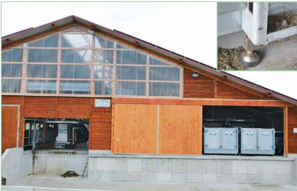
Wenn dezentrale Bereiche nicht in die Fütterungsstrecke integriert werden können, muss eine Möglichkeit eingeplant werden, für diese Tiergruppen Rationen mit der vorhandenen Technik zu mischen und an einer Übergabestelle (Bilder: System Wasserbauer) zwischenzulagern. Die exakte Beschickung des Mischers ist sensorgesteuert. Wiegezellen (kleines Bild: Wiegefuß) gewährleisten eine hohe Dosiergenauigkeit.
