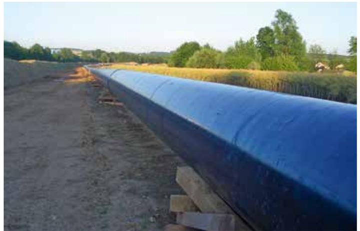
Beim Energieleitungsbau sind Eingriffe in den Boden durch Umschichtung, Vermischung, Befahrung und Verdichtung nicht vermeidbar. Maßnahmen zum Bodenschutz sind über die gesamte Bauphase zu treffen. Foto: Moe
