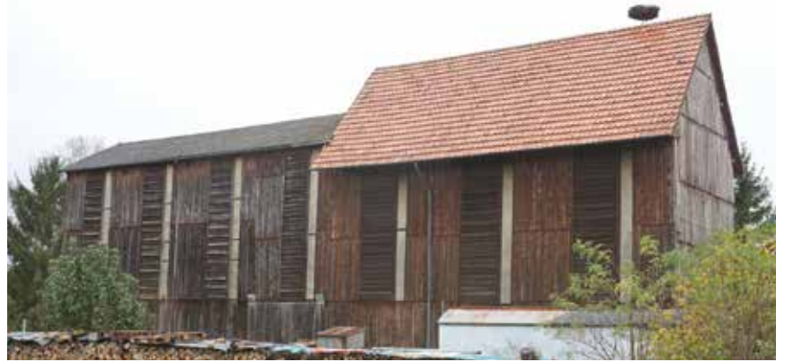
In diesen Tabakschuppen aus Holz wurden die Sorten Geudertheimer und Burley über Jahrzehnte getrocknet. Ab den 70er Jahren verbot die Berufsgenossenschaft den Bau von hohen Tabakschuppen, sie mussten dann flacher gebaut werden. In der Südpfalz stehen die Tabakschuppen als Relikte in zahlreichen Dörfern, wie Hayna oder Herxheim.
