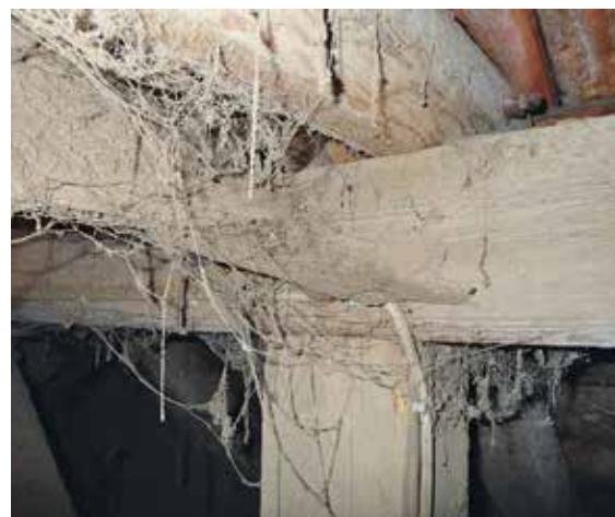
Mangelnde Sauberkeit im Gebälk bietet Schädlingen Schlupfmöglichkeiten.
