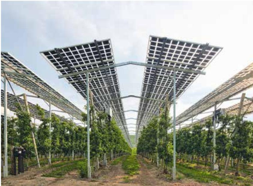
PV-Anlagen über Obst ermöglichen durch die Beschattung höhere Erträge – beispielsweise bei Äpfeln. Fotos: Fraunhofer ISE
