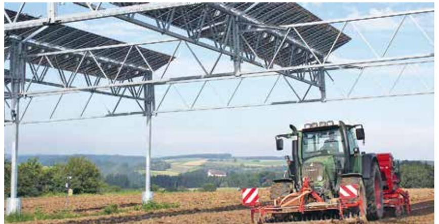
*Eine Aufständigung der Module, welche auch die Bearbeitung mit großen Landmaschinen erlaubt, ist nicht billig.*
