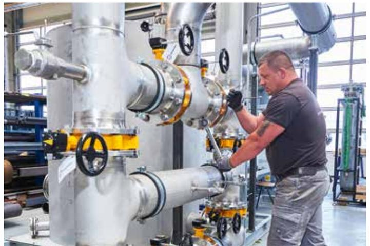
Um Biogas ins Netz einspeisen und anderenorts nutzen zu können, müssen unter anderem größere Mengen Kohlendioxid abgetrennt werden. Um dieses CO<sub>2</sub> nutzen zu können, hat die ETW Energietechnik die CO<sub>2</sub>-Verflüssigungsanlage in die Biogasreinigung integriert.
