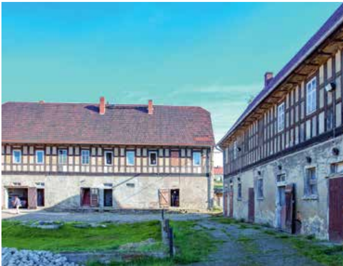
So wie diese Nebengebäude warten viele Vierseithöfe im Altenburger Land auf eine ressourcenschonende Instandsetzung
