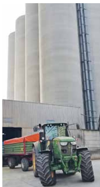
Bis Ende des Jahres soll die Annahmestelle für Landwirte auf 1 000 t/Tag erhöht werden.
