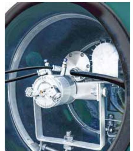
Mit der KI-Kamera von PlanET Biogastechnik wird erstmals ein KI-basiertes System zum automatischen, bedarfsgerechten Rühren in Biogasanlagen vorgestellt.
