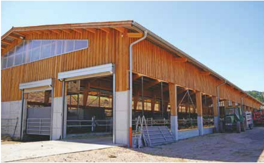
Eine Längsseite des Stalls ist offen (linkes Bild), an den Stirnseiten befinden sich je zwei Netz-Rolll Tore. An der anderen Längsseite des in den Hang gebauten Stalls wurde ein überdachter Auslauf geschaffen (rechts). Dieser ist innen mit einem zweischichtigen Windschutznetz ausgestattet, das im Bedarfsfall bis zu 98 Prozent Windstopp möglich macht. Auf beiden Längsseiten gibt es einen Futtertisch, das Futter ist durch das Dach auch außen stets geschützt. Die Baubetreuung erfolgte durch die Hessische Landgesellschaft.
