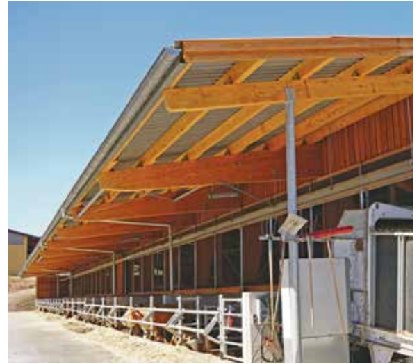
Eine Längsseite des Stalls ist offen (linkes Bild), an den Stirnseiten befinden sich je zwei Netz-Rolll Tore. An der anderen Längsseite des in den Hang gebauten Stalls wurde ein überdachter Auslauf geschaffen (rechts). Dieser ist innen mit einem zweischichtigen Windschutznetz ausgestattet, das im Bedarfsfall bis zu 98 Prozent Windstopp möglich macht. Auf beiden Längsseiten gibt es einen Futtertisch, das Futter ist durch das Dach auch außen stets geschützt. Die Baubetreuung erfolgte durch die Hessische Landgesellschaft.
