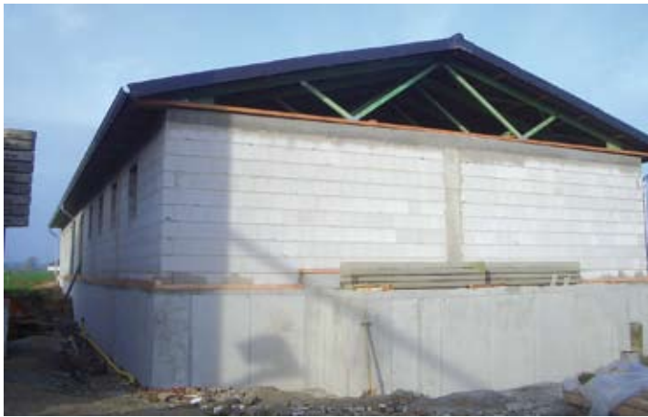
Bis der Rohbau des neuen Stalls steht, sind viele Hürden zu überwinden. Fotos: Moe
